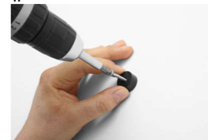
Montage des Wandbefestigers für Duschvorhangstangensystem
