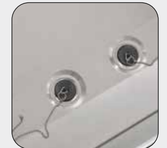
Abflusslöcher mit Ablaufventil, Stöpsel und Kette
